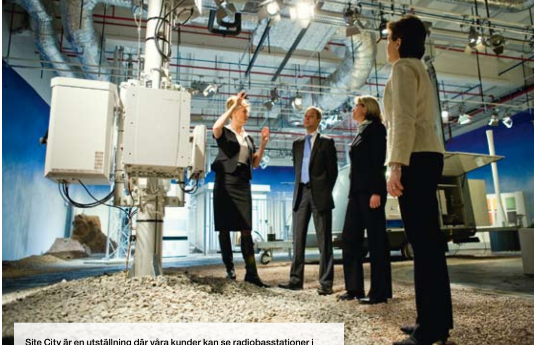
Site City är en utställning där våra kunder kan se radiobasstationer i olika miljöer och för olika behov.
