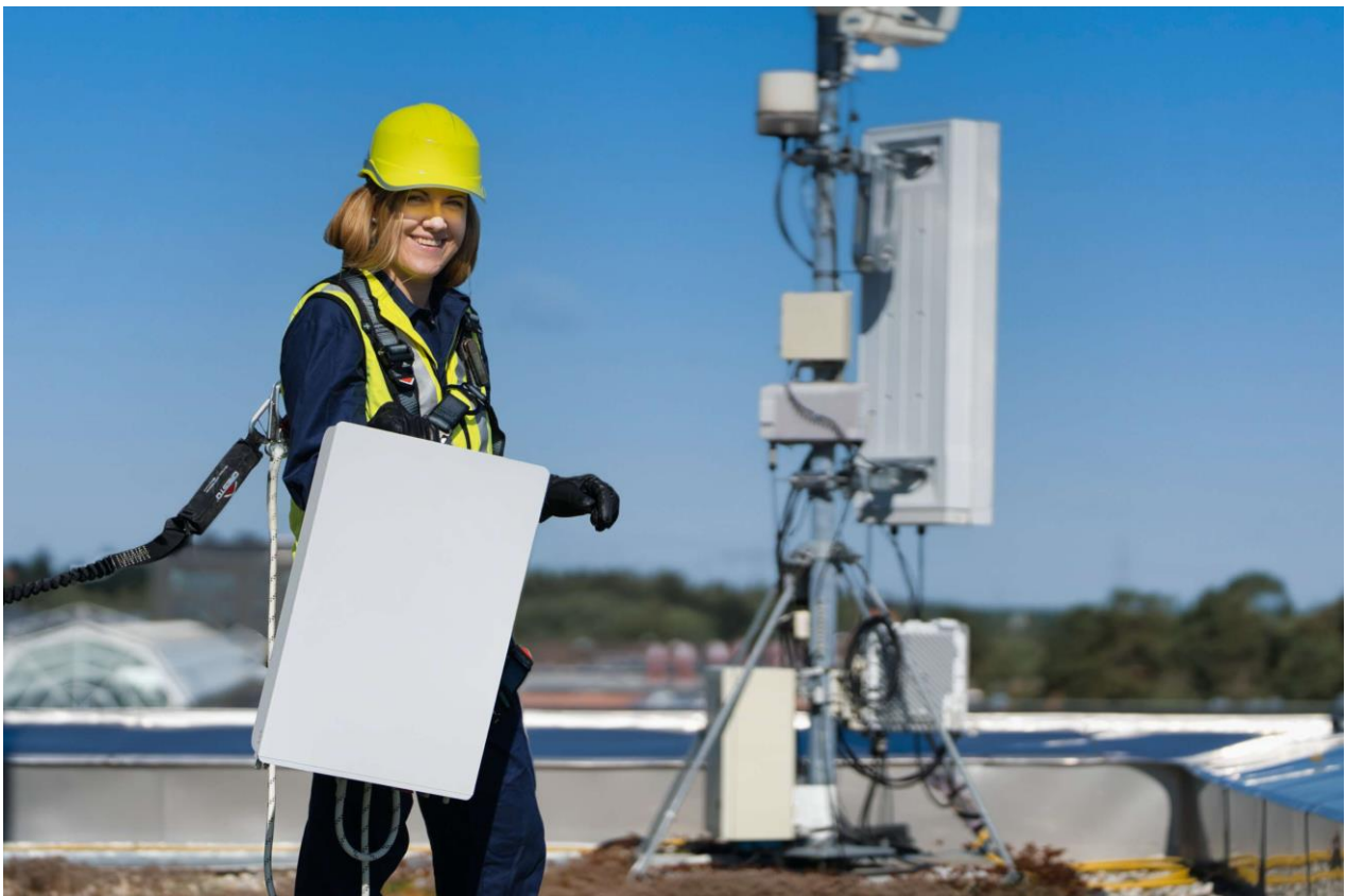
Ericsson Air 3268 Radio-Rollout auf einem Dach
