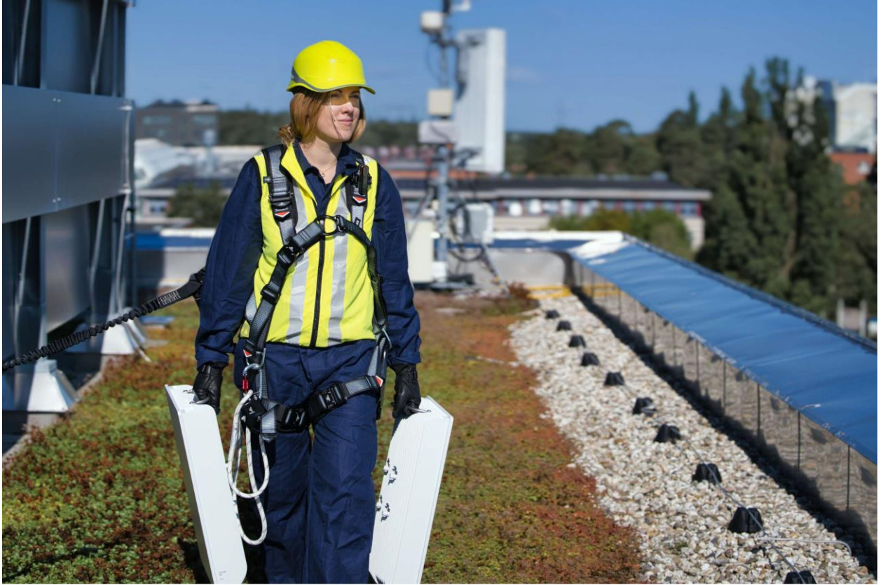
الشكل 1: تركيب جهاز الراديو Air 3268 على إحدى الأسطح.
