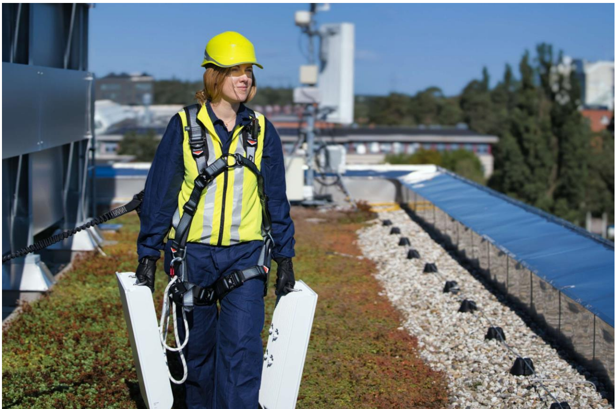
Figure 1 : Installation sur le toit de la radio AIR 3268.
