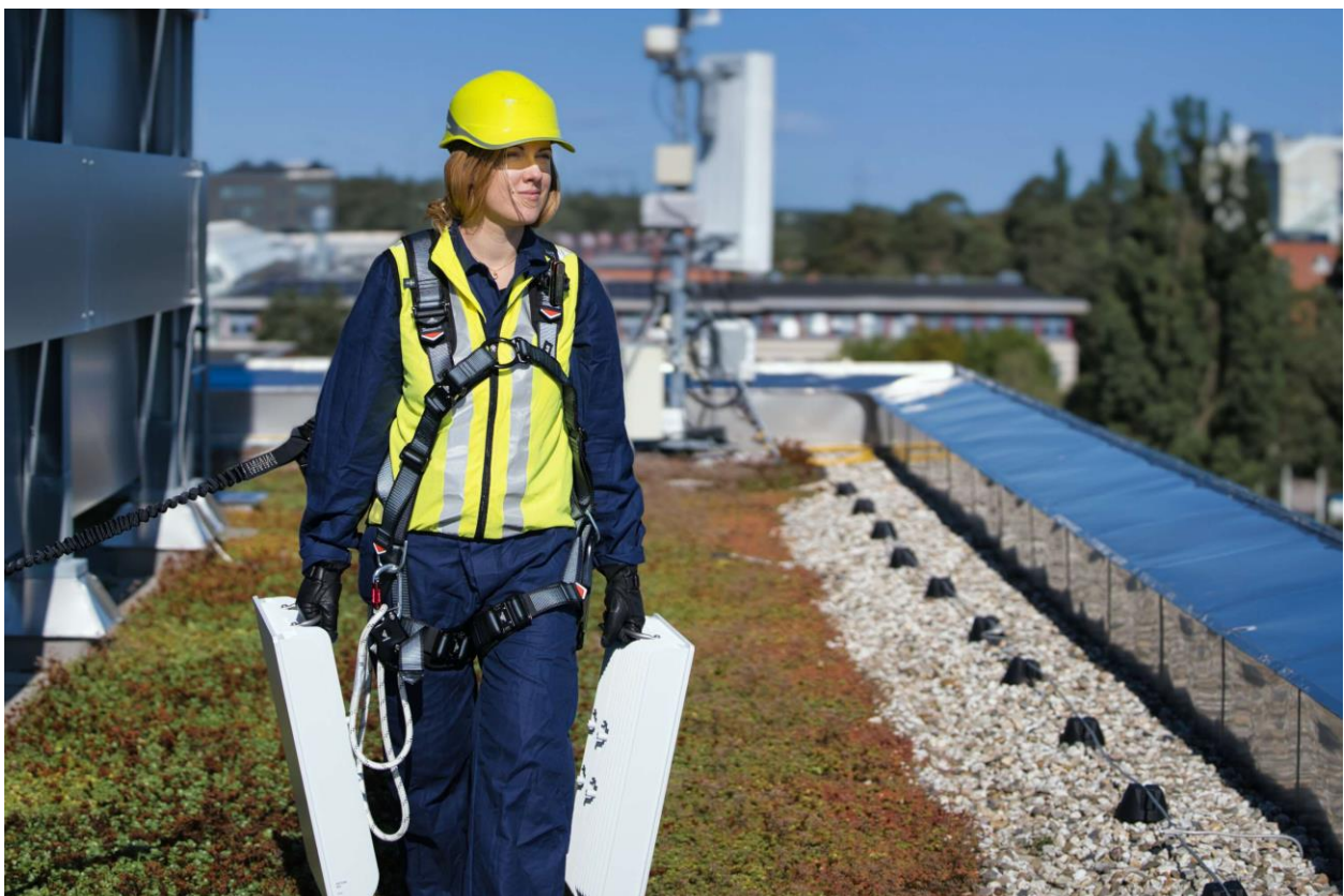
Abbildung 1: Installierung eines Air 3268 auf einem Dach
