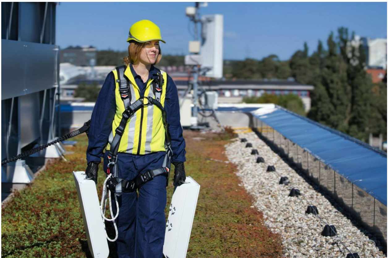
Figura 1: installazione di un'antenna Air 3268 su un tetto.
