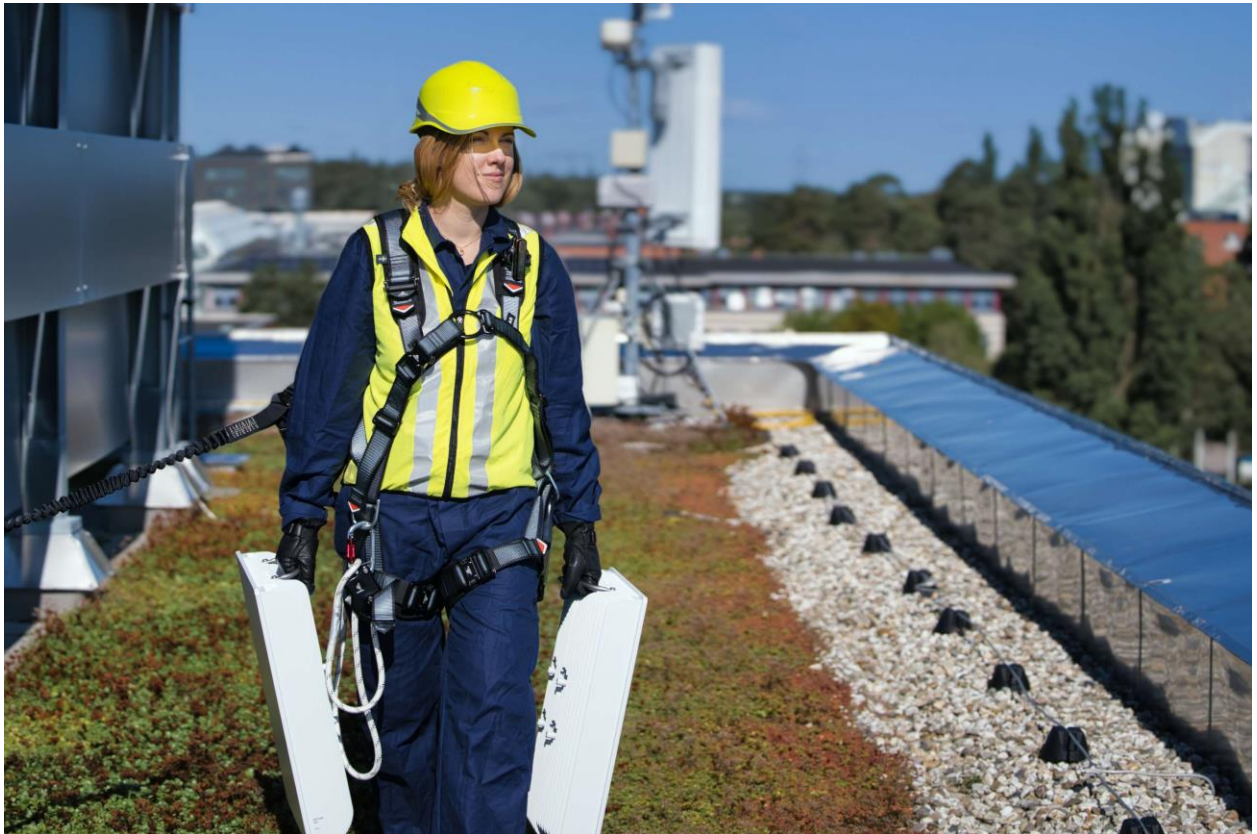
그림 1: Air 3268 옥상 설치.
