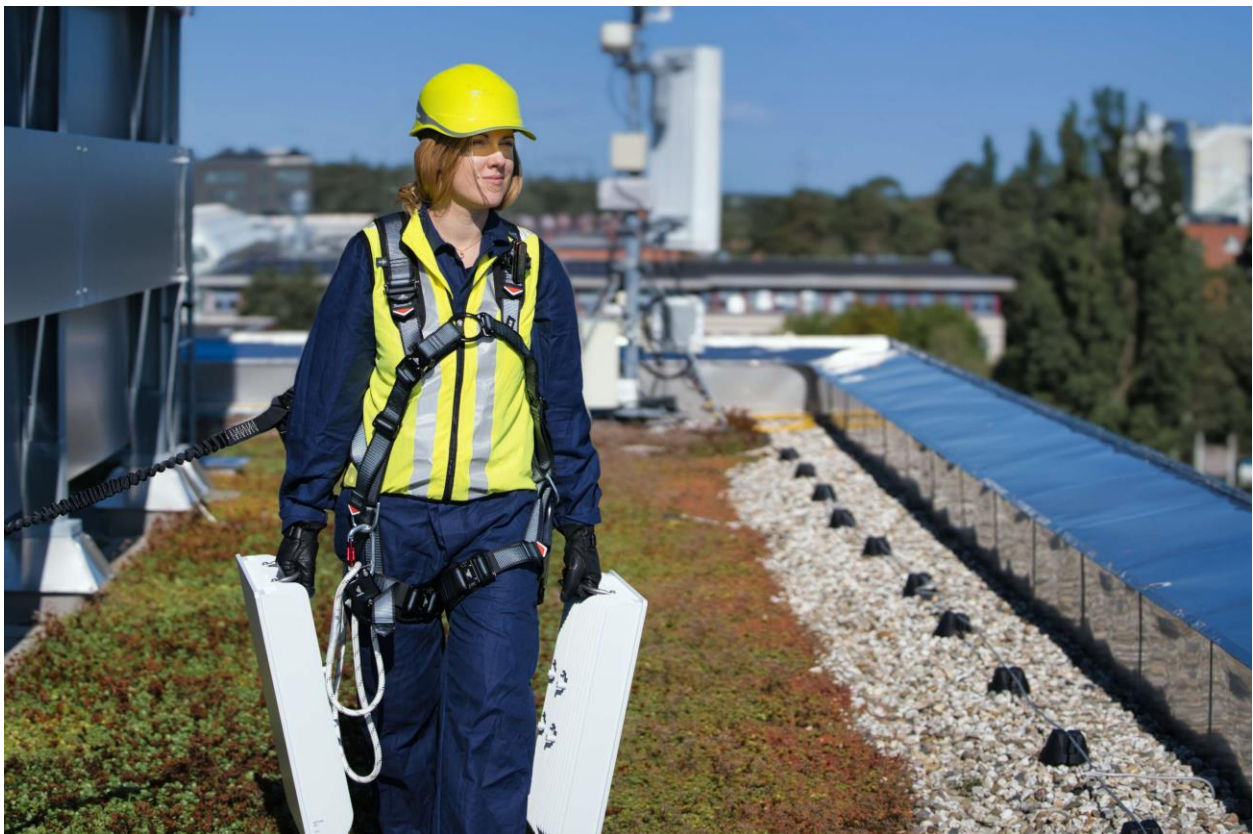
Figura 1: Instalação de telhado do Air 3268.
