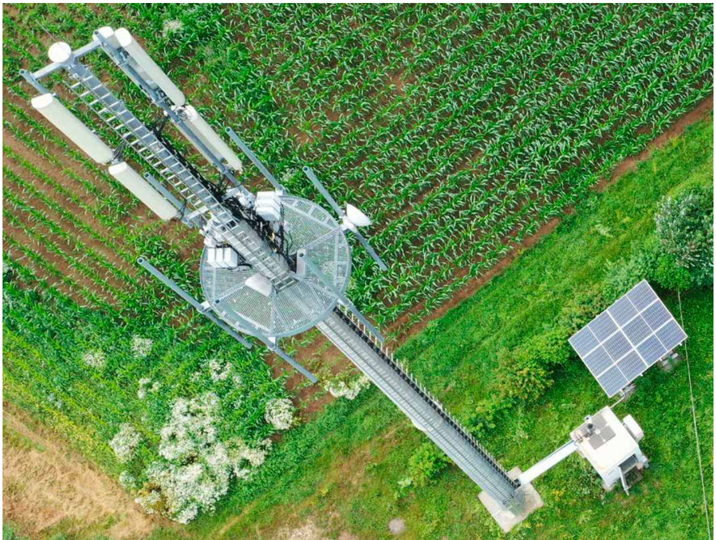
Ericsson och Deutsche Telekom har ingått partnerskap för att installera solpaneler på en plats för radioaccessnät. Bildkälla: DFMG Deutsche Funkturm GmbH.
