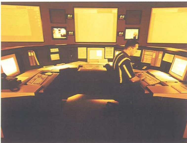
NÄTÖVERVAKNINGSCENTRAL I RICHARDSON, USA
