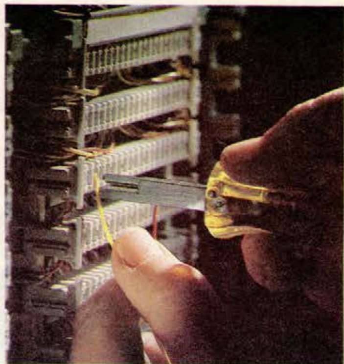
Stora tidsvinster görs genom den enkla inkopplingen i slitsplintar.
