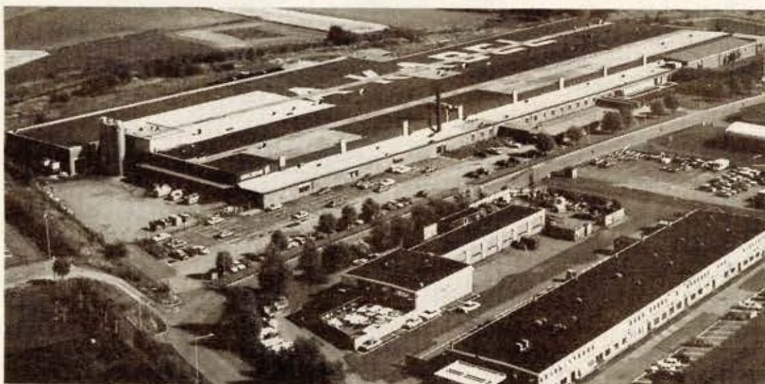
Vid Ericsson Cables fabrik i Kungsbacka produceras s k specialkabel. Den tillverkningen kommer nu att flyttas till Falun och Hudiksvall.
