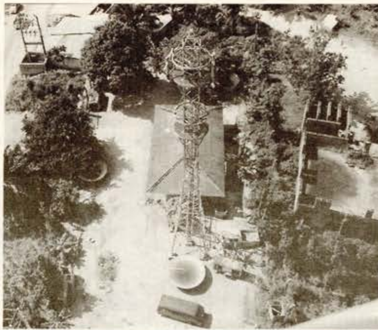
Inom ett år ska Nigeria ha ett mobiltelefon-system för 7500 abonnenter. En av basstationerna byggs vid Ipara, norr om Lagos.
