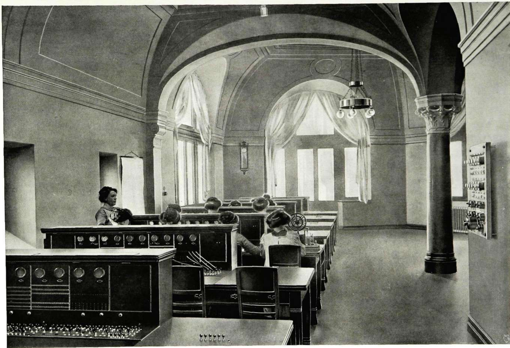
Le bureau central à Helsingborg, Suède Tableaux pour communication interurbaine
