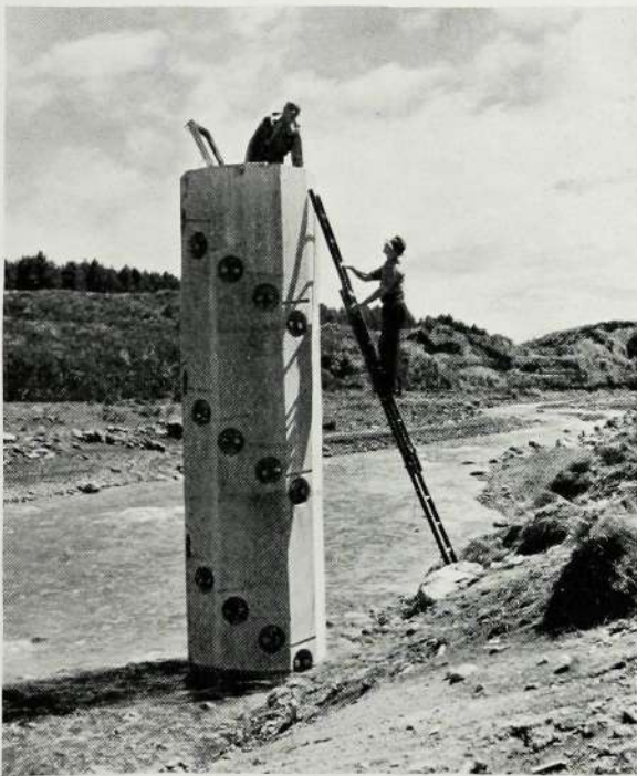
Fig. 2—The Gauging Point
