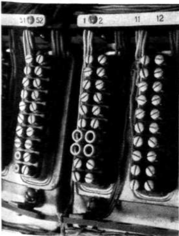
Fig. 10 Skyddshylsor NBM 1201, placerade i kopplingsboxar
