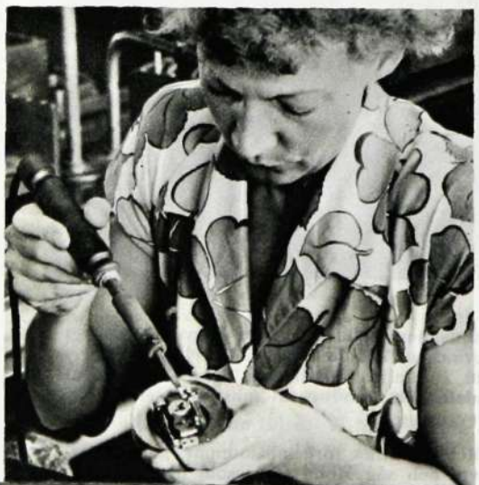
När impulsjusteringen är klar, sker förbindning och lödning av kabel till fjädergrupp
