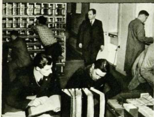
Arbetet i »korskopplingen» är hektiskt under överkopplingstimmerna. Linjerna kontrolleras med ledning av linjerullorna, provisoriska korskopplingsstrådar dras ut och nya läggs in. Förste byråingenjör Å Strandén kommer just för att ta en titt på arbetet.
