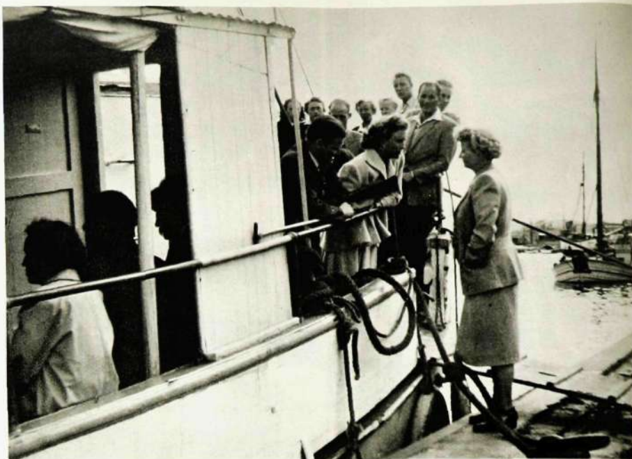
Gullmaren gör sig redo att lägga ut med ett 100-tal Alpha-iter ombord.
