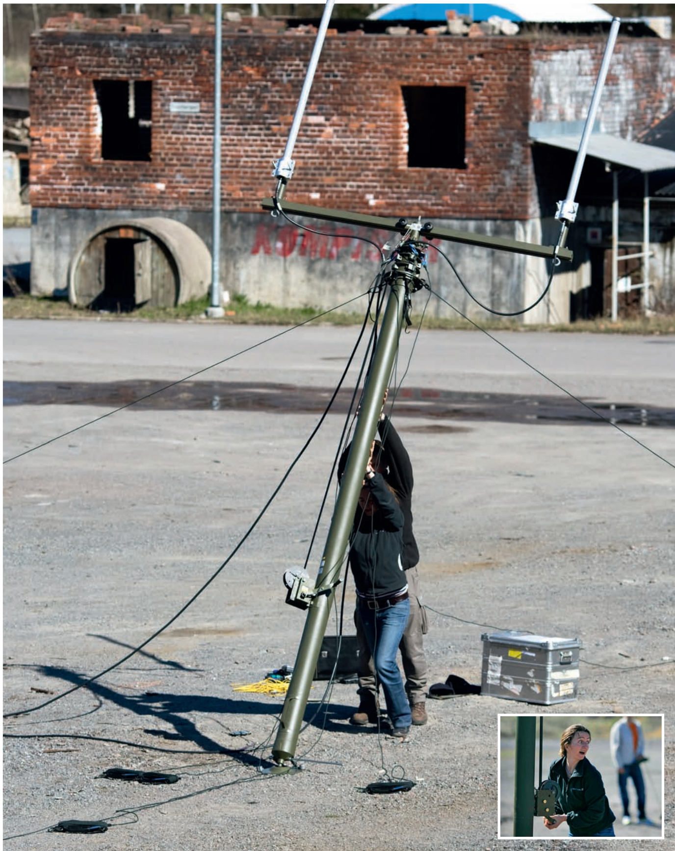
Det tar bara några minuter för räddningspersonalen att resa masten för Quiclink-systemet. När stöddlinorna är förankrade vinschar Ester Gonzalez de Langarica från Ericsson Response upp de påhakade antennerna till cirka femton meters höjd för att få bra täckning.
