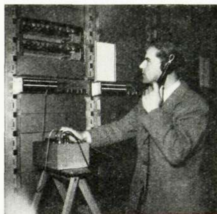
Världens nordligaste automatstation är inrymd i ovanstående fastighet. Det var bråda timmar före överkopplingen och ingenjör Sven Åskehölm ses här i färd med slutprovning av en reläutrustning. Nedan kontrollerar förman Arne Thorelli att allt fungerar riktigt.
