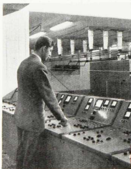
Ingenjör Åke Ahlström reglerar spänningen på en transformator från manöverbalkongen som löper längs hallens ena långsida.
