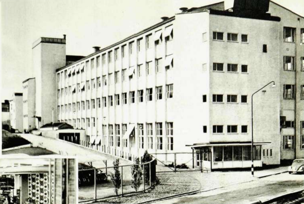
Den vita fasaden på LM:s filialfabrik i Karlskrona höjer sig djärvt över omgivningen, och från fönstren i de övre våningarna har man en vacker utsikt över hamnen.
