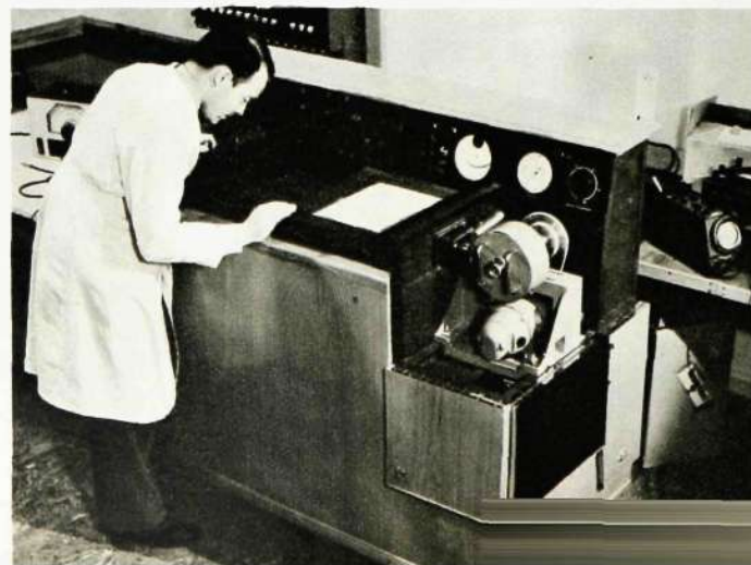
Ingenjör Nils-Åke Åkersson undersöker några snabba elektriska förlopp med mångkanaloscillografen.
