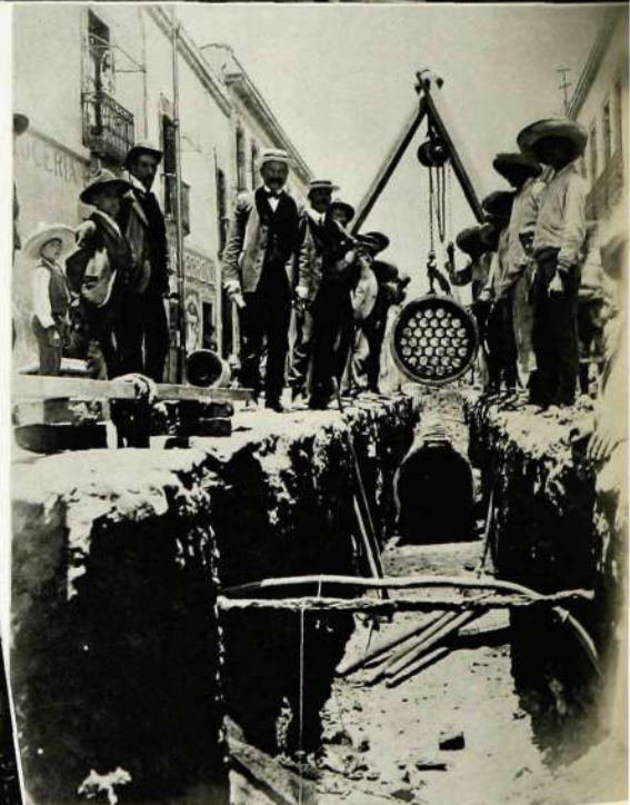
I början av år 1905 begynte Telefonbolaget lägga grunden till de omfattande anläggningarna i Mexico. Ovanstående bild är tagen detta år och visar nedläggandet av telefonrummor för Victoria Centralen i Mexico City. I gruppen t. v. ses bl. a. de båda pionjärerna K V Gerdhem (i plommonstop) och J Sitzerstatter (i halmhatt).
