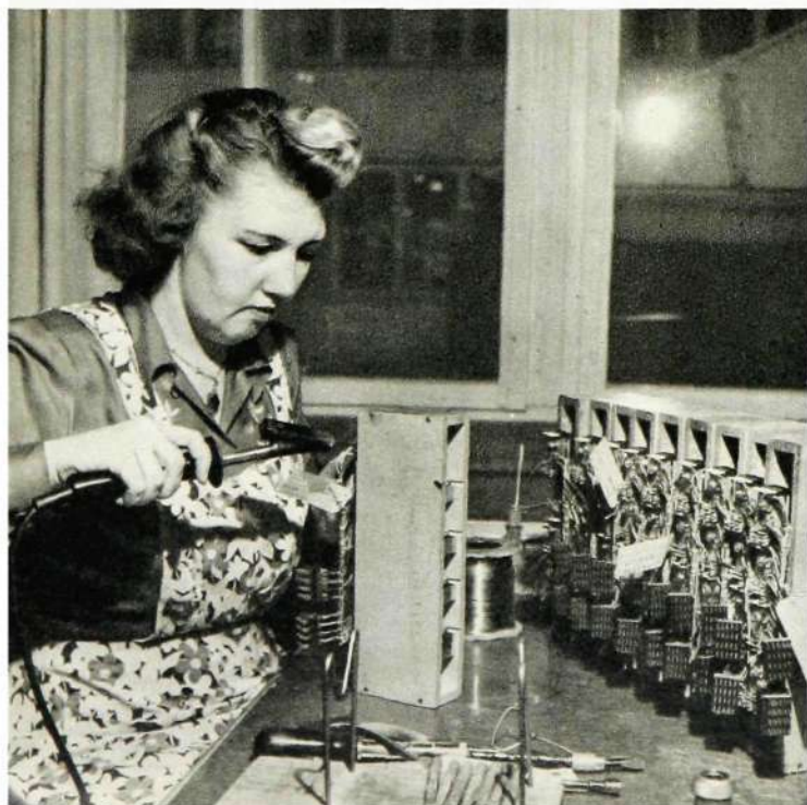
Fru Ingegerd Lilius löder fast en kabel på relä-fästen.
