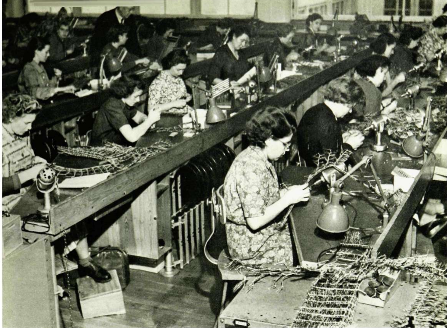
Trådar i olika färger sys på Vt 32 samman till kabelknippen. Det är huvudsakligen kvinnlig arbetskraft som sysselsätts på denna avdelning.
