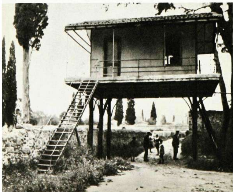
Till skydd mot rövare in-rymdes en del telefon-stationer i Izmir (Smyrna) i stolpförsedda hus som låg bakom höga stenmurar.
