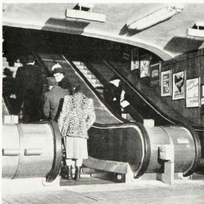
Fotocellanläggningen för rulltrapporna till tunnelbanestationen vid Fridhemsplan.
