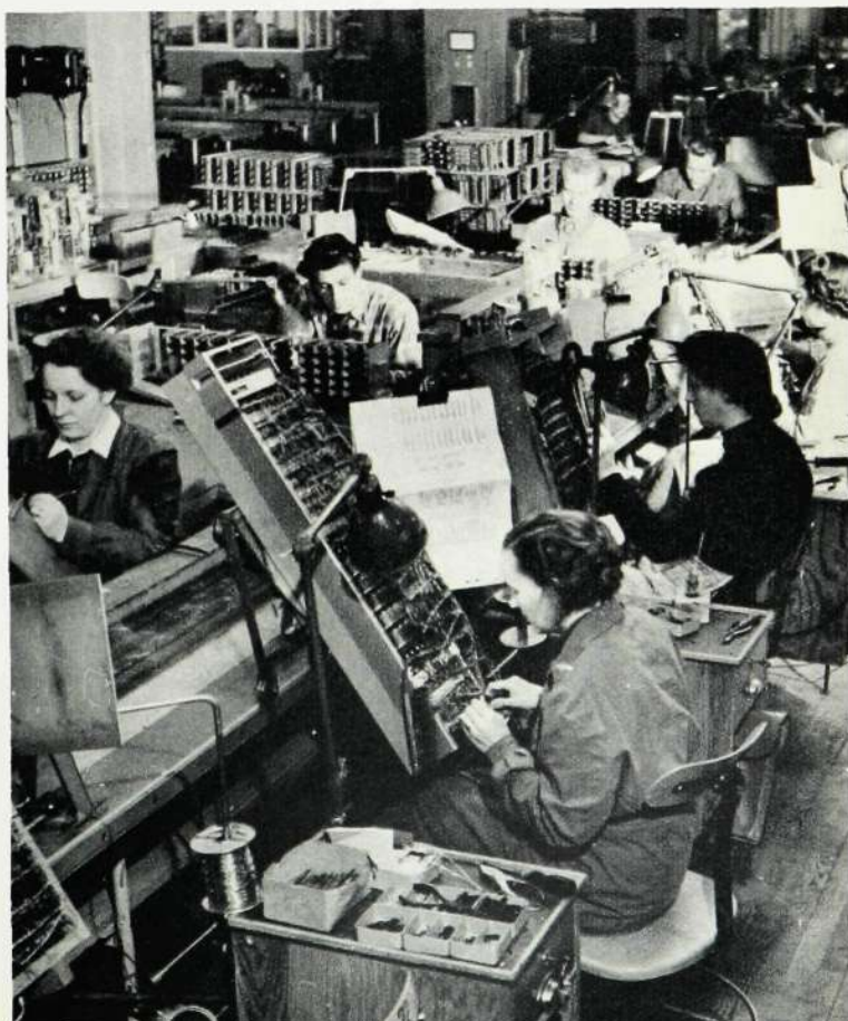
Fru Hilda Johansson är en av veteranerna på avdelningen, som hela tiden hållit på med att koppla och löda stativ.
