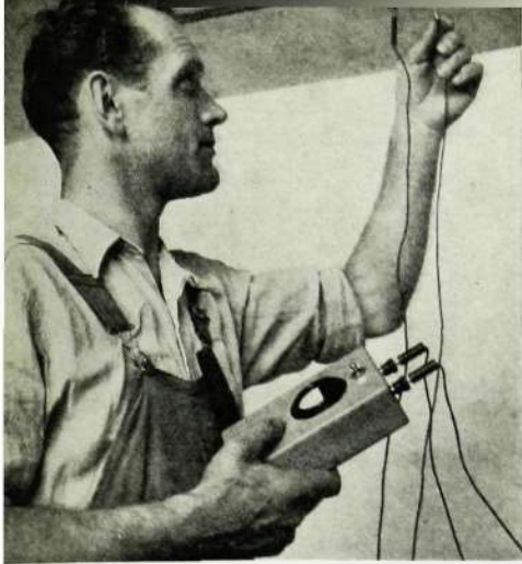
Montören Kalle Hurlig i färd med att montera automatiskt brandlarm.
