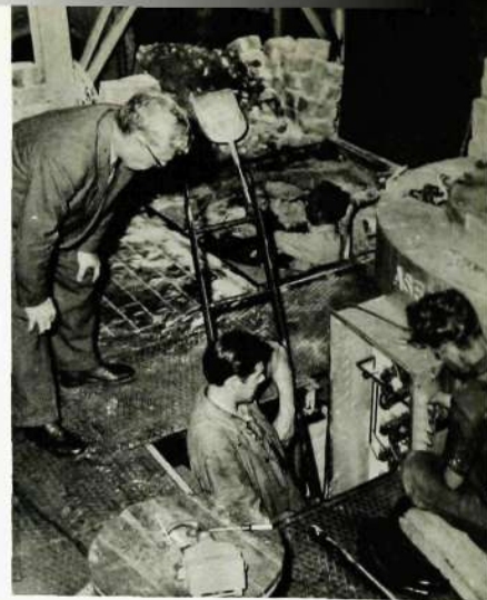
Vid pressningsavdelningen hade man satt igång med ett stort semesterarbete med att installera en ny gropugn. I bakgrunden ses Jevgenjis Dislers kasta upp jord från den grop han gravt i golvet, medan montörerna Åke Larsson och Uno Egering sysslar med elektriska installationsarbeten. Längst tv ingenjör Uno Johansson.
