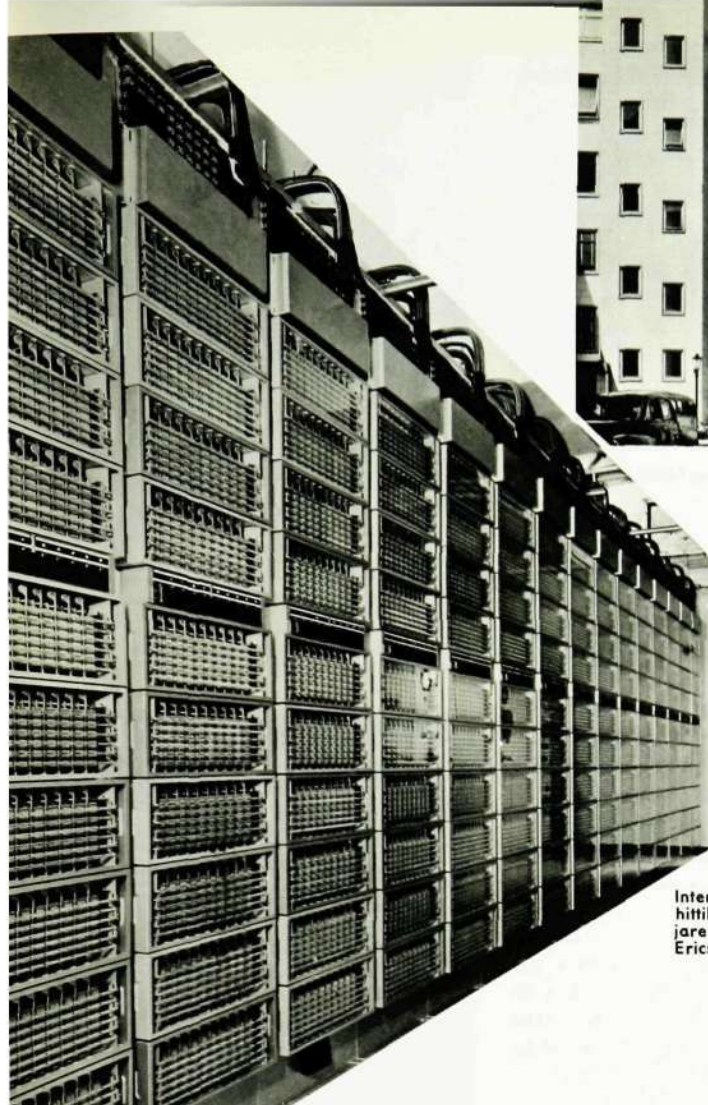
Huvudstationen i Århus omfattar 20 000 linjer. Dessutom finns en automatisk interurbanstation med s k snörlösa expeditiionsplatser.
