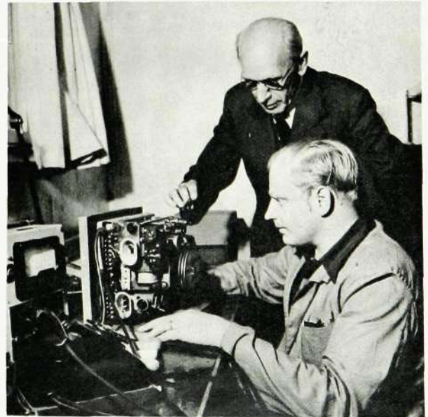
Telefonsvararen är inrymd i en kåpa av plåt, lackerad i grått. Telefonapparaten placeras på manöverstället. Den »idiot-säkra» intalningsknappen synes inom den vita ringen till vänster.
