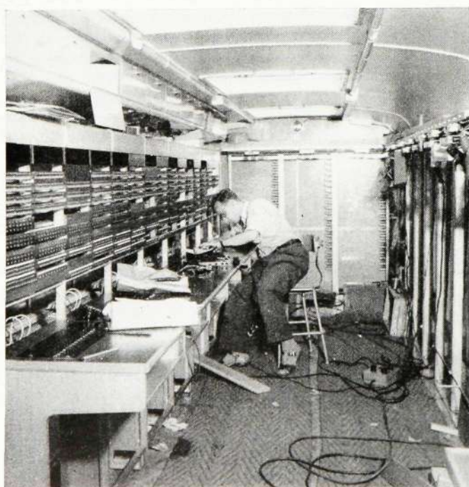
En interiör av bussen, där praktikant Paavo Luukko, Ms, just är i färd med monteringsarbeten vid växelborden.
