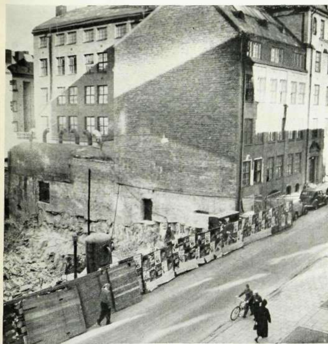
Med direkt anslutning till den gamla fastigheten kommer det nya komplexet att resa sig på den tomt, där grundarbetena nu pågår för fullt.
