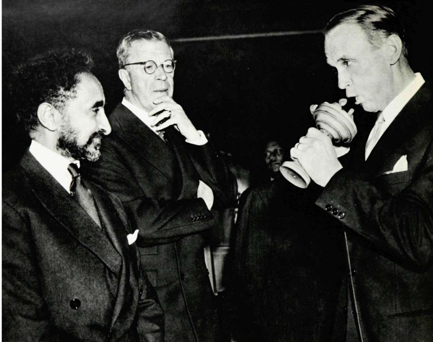
Det är ingen leksakstrumplet utan den första LM-telefonen från 1879 som direktör Sven Ture Åberg demonstrerar för en road kejsare och en något fundersam kung. »Blåsningen» var nämligen sättet att ge signal med den tidens telefonapparat.
