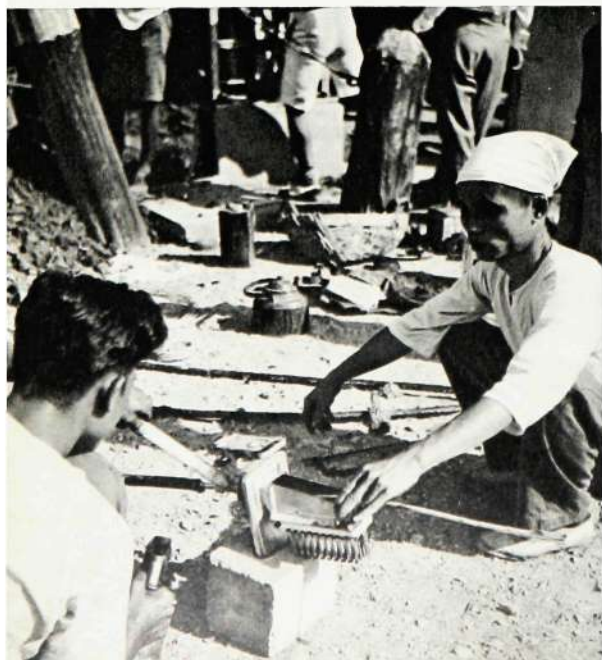
Två siameser i arbete med att löda en 10 pars säkringsbox direkt till en armerad kabel.
