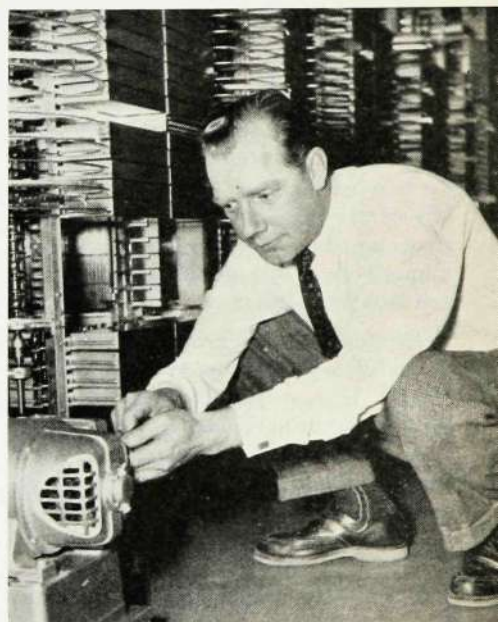
Överst gör ingenjör Sven Lundberg, som förestått provningen, och ingenjör Nils Andersson, chef för landsortsmontagen, en sista kontroll av trafikmätarna på automatstationen i Halmstad.
