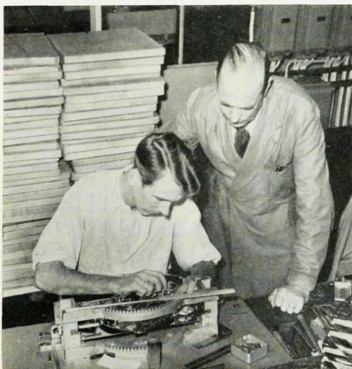
Hr Gösta Berg monterar propptången på 500-väljaren under, överinseende av förman Gösta Eriksson, tidigare vid Huvudfabriken.
