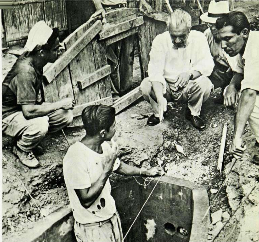
Ingenjör Rogowsky. Nu, instruerar några arbetare vid byggandet av en kanalisationsbrunn i Guayaquilla i Ecuador.
