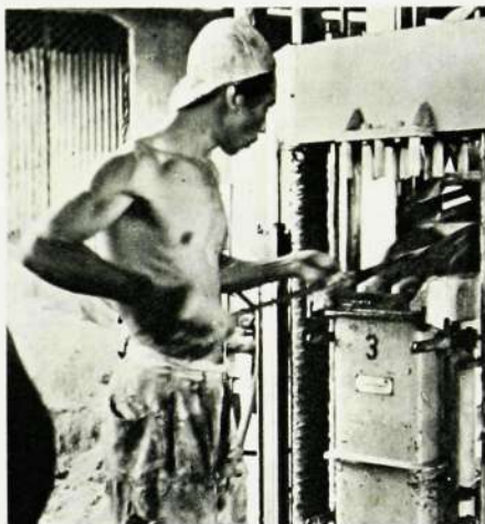
I Barranquilla, Colombia, arbetar man med tryckvibrationsmaskin för tillverkning av 4-pipsblock.
