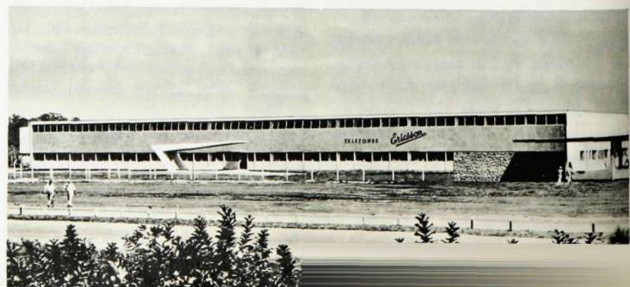
Exteriör av L M Ericssons telefonfabrik i São José dos Campos i närheten av São Paulo.
