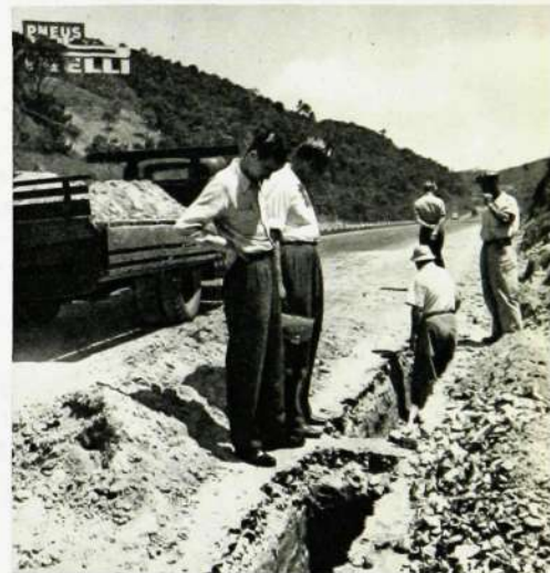
Vägen mellan São Paulo och Santos. Här grävs kanalisationsbrunnar för koaxialkabel.
