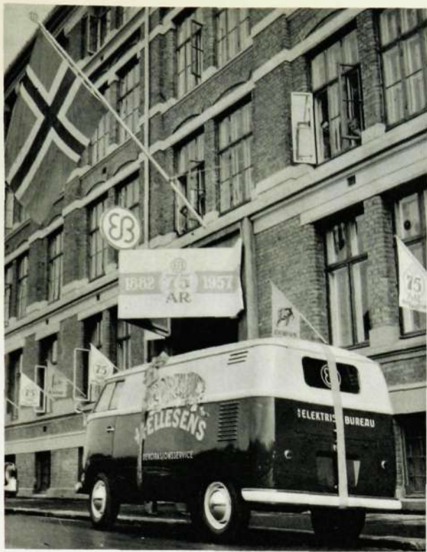
I dagarna tre flaggade Elektrisk Bureau i Oslo. Anledningen var att det LM-anknutna norska bolaget fyllde 75 år i maj. Det här är fasaden mot Middelthunsgaten.
