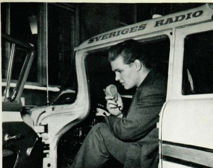
I en artikel i detta nummer berättar vi om radiodirigerade bilar i Hofors. Även i Stockholm har avstånden blivit så stora att det är ekonomiskt att ha radio i bilarna. Sveriges Radio har för sin del utrustat sin vagnspark med SRA kommunikationsradio. Bilden visar en av radions-televisionens reportagebilar.
