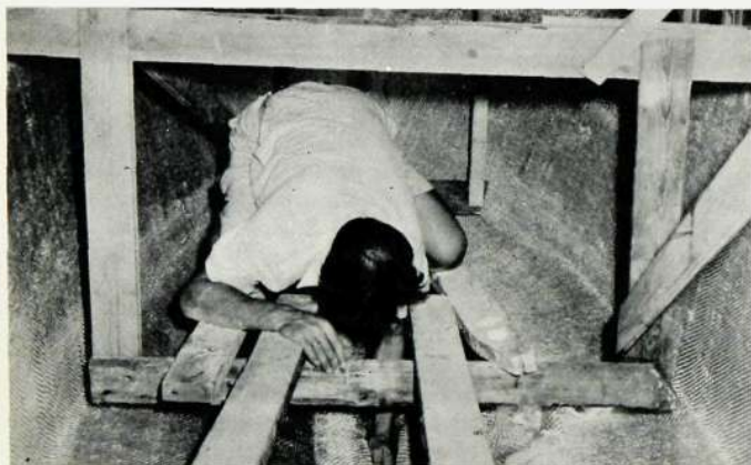
Bygget har kommit så långt att glasfiberväven kan läggas på plats. Förf. idkar akrobatiken.
