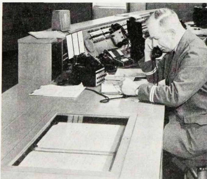
T v en bild från Tunnelcentralen i Gamla Stan. Tågklareraren har t v om sig centralens allt seende öga, tågtidskrivaren från Signalbolaget.
