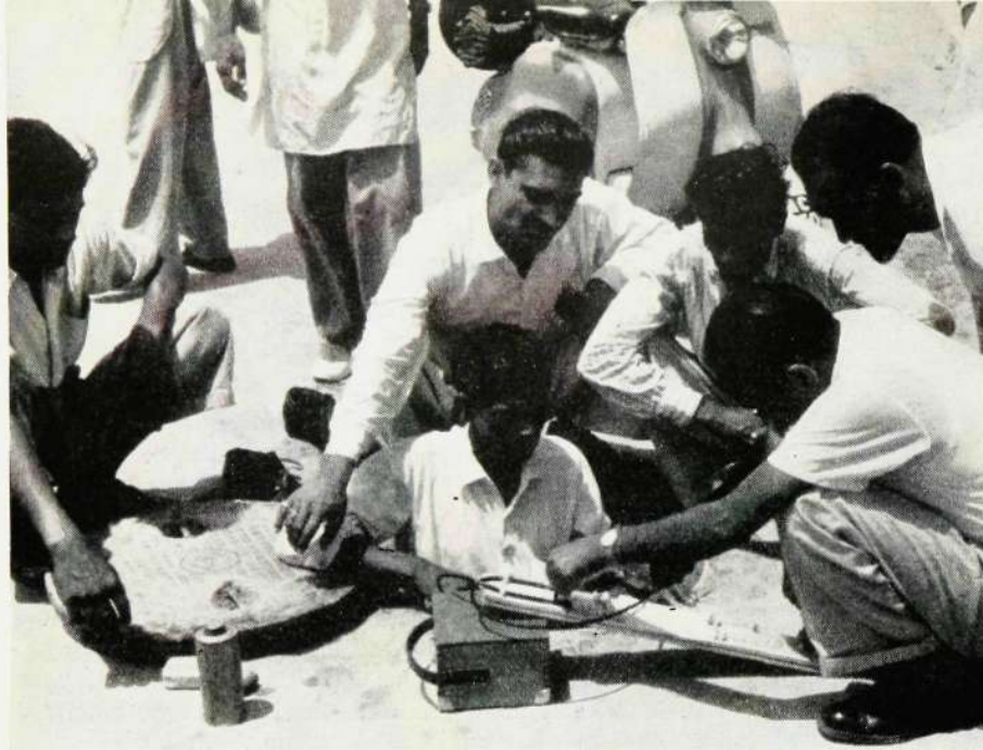
Bilden visar ett gaskontrollteam i Karachi, sysselsatt med att lokalisera en läcka på en trunkkabel.
