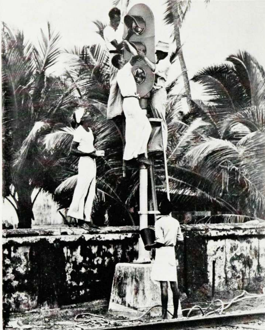
Bilden ovan visar montering av en ljussignal-skytt vid en järnvägslinje på Ceylon, vars signalsystem SIB svarar för. Det är som synes enbart infödd arbetskraft som utför monteringen under ledning av en ingenjör från SIB.
