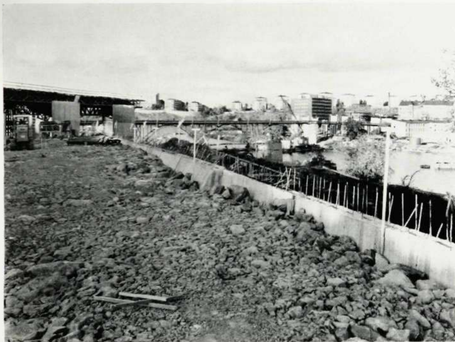
Gröndalsbron är bara klar fram till Lövholmsvägen. Bropelarna är gjutna men brobalkarna saknas ännu. Bilden ovan.
