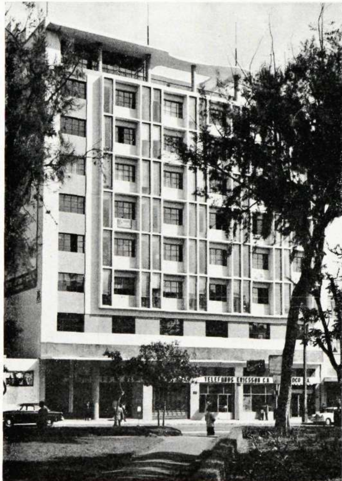
L M Ericssons försäljningsföretag i Ecuador, Telefonos Ericsson C.A. i Quito har fått nya lokaler. Nedan det nybyggda husets statliga framsida.
