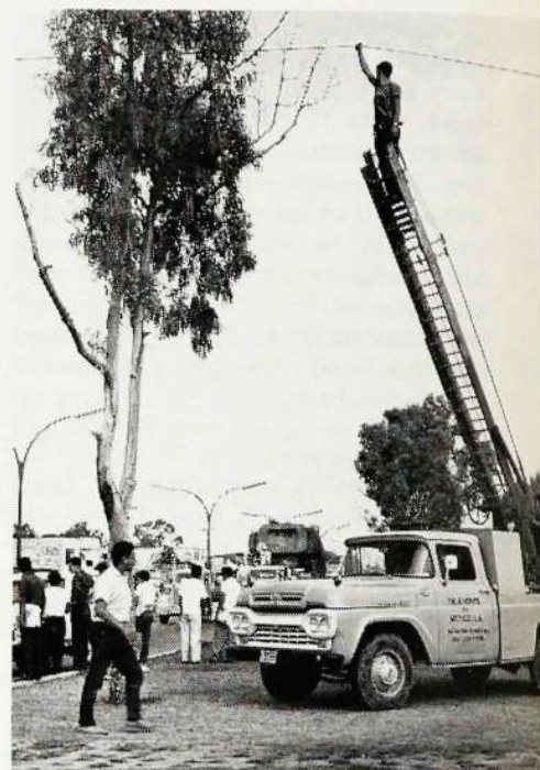
Här lyftes en av de 1327 telefonledningarna för att ge plats åt Tlaloc.
