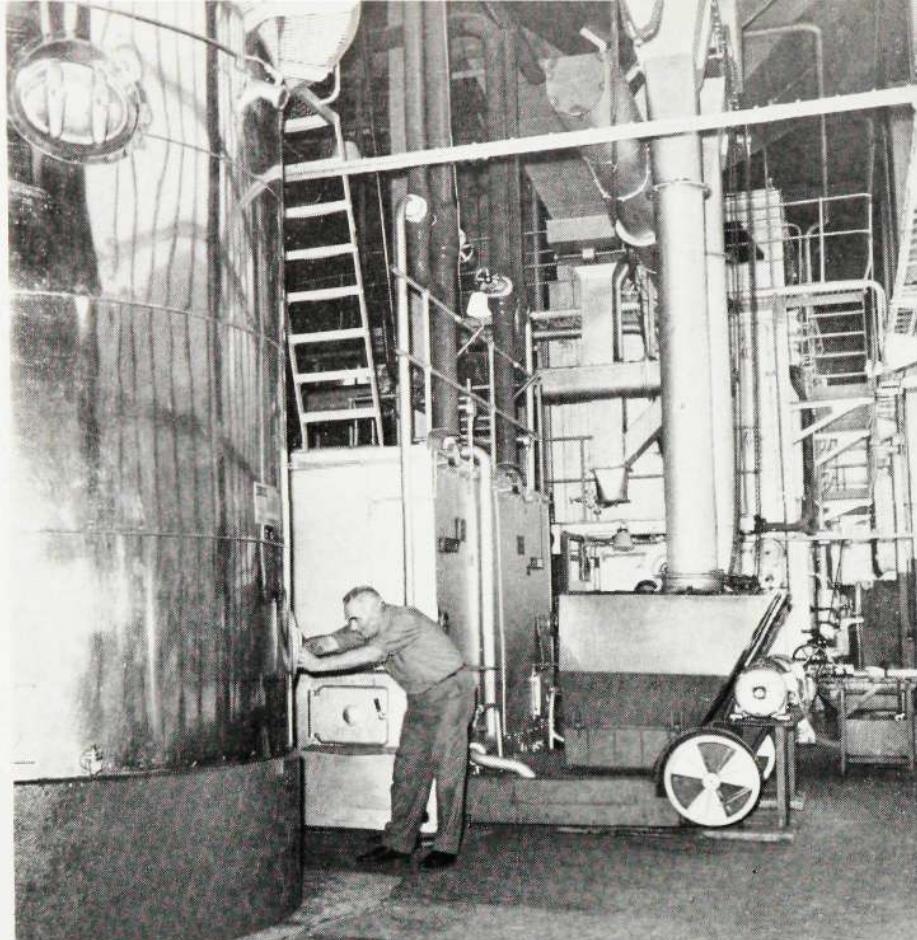
Bilden t. v. visar äldst och yngst. T. v. den nyaste pannan som har fyra gånger så stor kapacitet som den äldsta t. h. Den kan ännu eldas med kol i händelse av strömavbrott.
