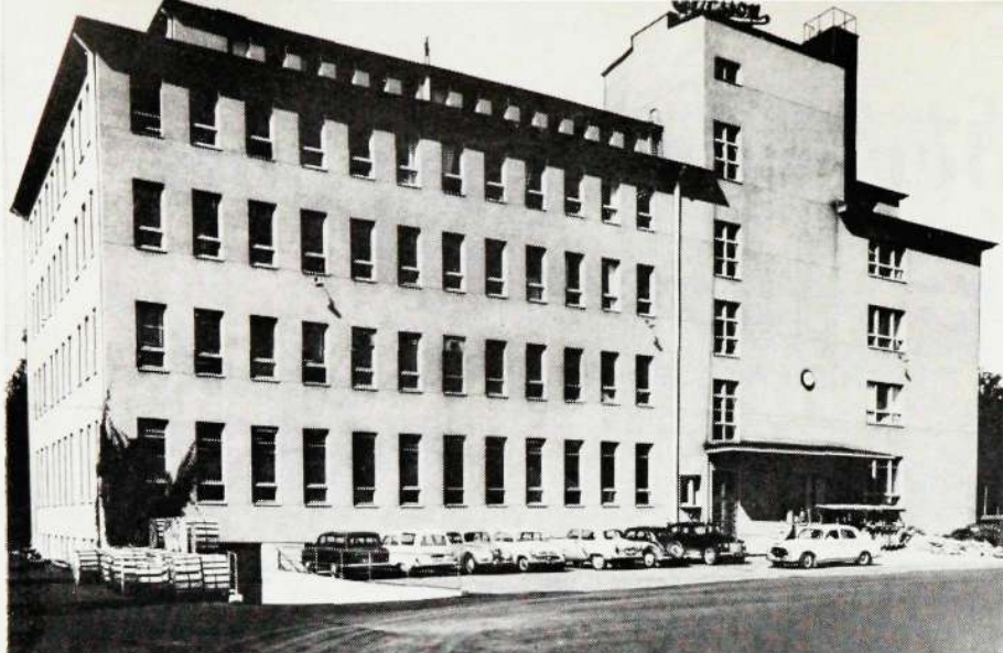
Bilden t.v. visar O/Y L M Ericsson AB:s huvudbyggnad i Helsingfors. Överst på vidstående sida den holländska fabriken, Ericsson Telefoon-Maatschappij N.V. i Rijen och nederst på sidan huvudentrén till Ateliers Vaucanson i Paris.
