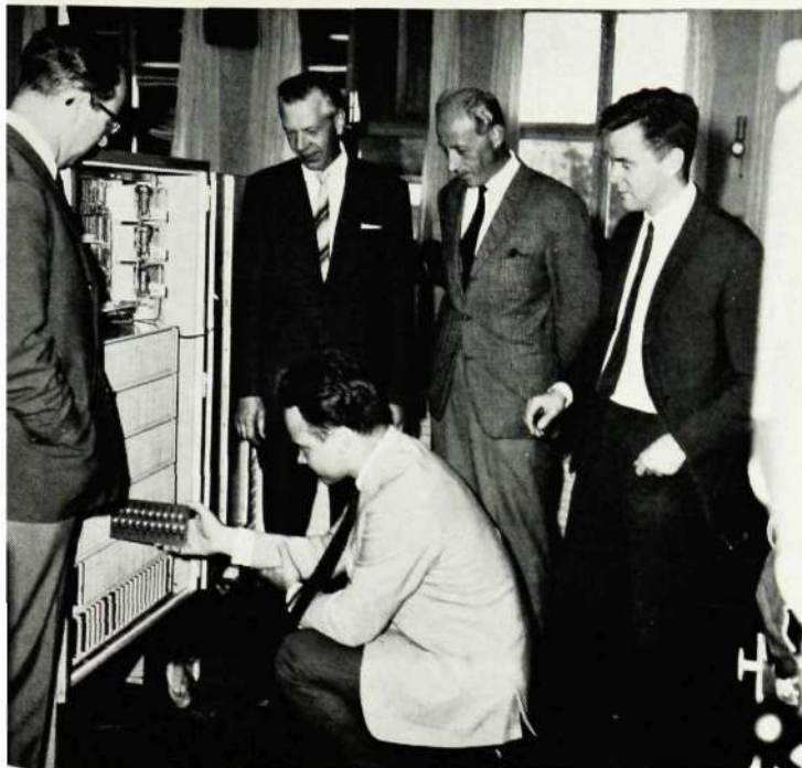
Casas tekniske chef Lars-Åke Boström demonstrerar ett av de 250 kretskort som ingår i logikdelen i den till Kh levererade automatiska spolprovaren. Åskådare är från vänster disponent Fagerholt, Kh, direktör Thomsson, Casa, ingenjör Finell, Kh, och ingenjör P O Svensson, Casa.
