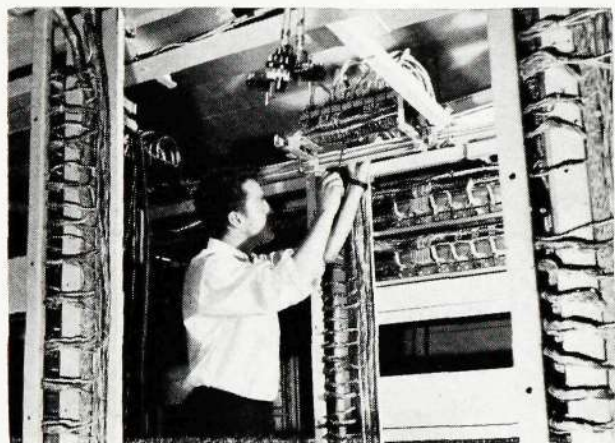
Leif Tolleson och provledaren Kjell Kanlén utför multipelprov i den nya växeln.
