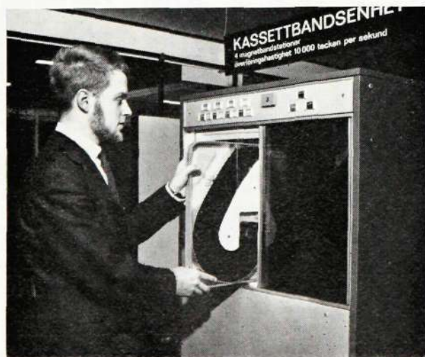
Bilden visar en ICT kassettbandsenhet som visades i L M Ericssons monter på utställningen Kontor 66. Byte av kassett sker med ett enkelt handgrepp. Bandet ligger i en ändlös slinga i kassetten.
