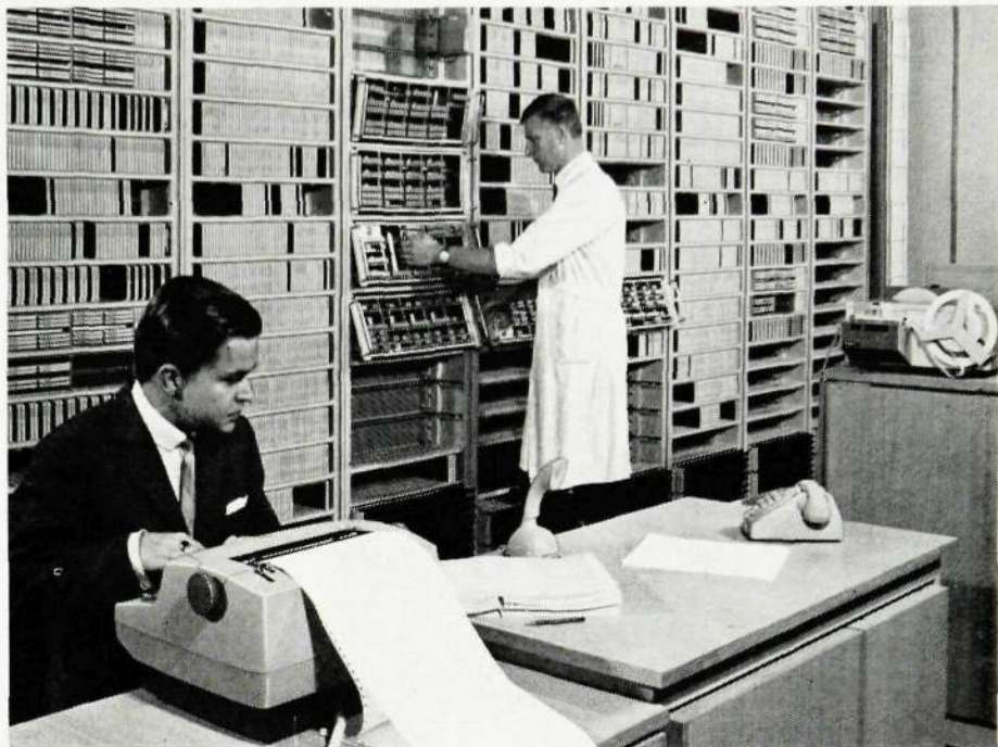
Programprovning i AKE-stationens kombinerade datamaskin och kontrollrum. Kommunikationen mellan människa och maskin sker med hjälp av skrivmaskiner, remsstans och remsläsare.
